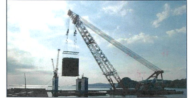
① 鋼殻吊込み(津松坂港)
