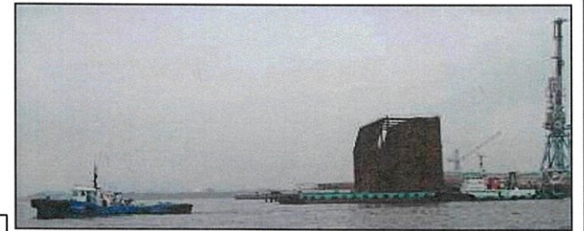
② 本体工 鋼殻海上運搬(津松坂港→清水港)
