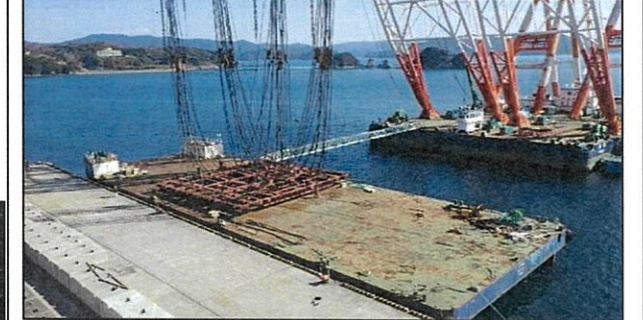
③ 吊枠ワイヤリング(起重機船)
