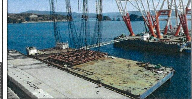
③ 吊枠ワイヤリング(起重機船)
